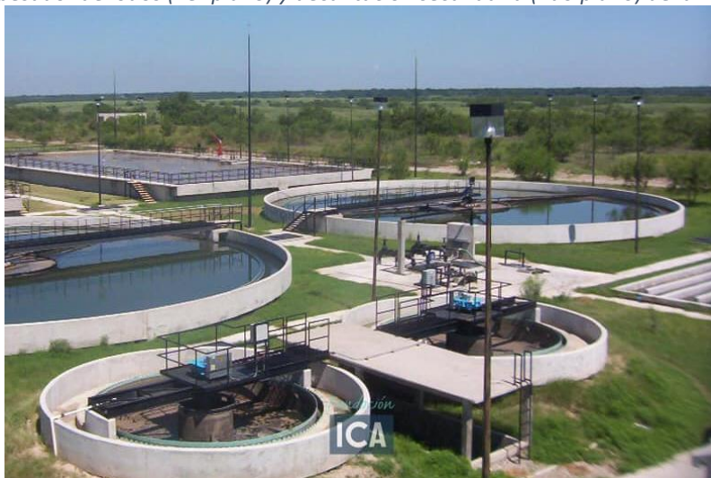
Ilustración 15. Espesador de lodos (1er plano) y decantación secundaria (2do plano) de la PTAR Acuña.
